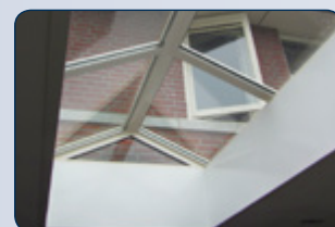
Zadeldak met kopse kanten van glas
